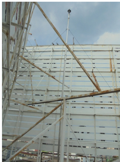
ภาพที่ 4-23 เสาล่อฟ้าและตู้ระบบบลงดิน
