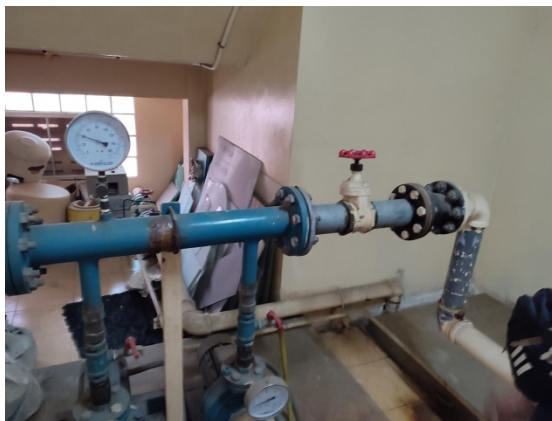
ภาพที่ 4-7 ระบบส่งน้ำประปาไม่พบรอยรั่วซึม
