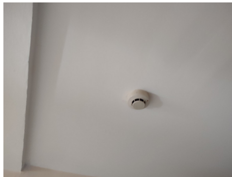
ภาพที่ 4-20 Smoke Detector
